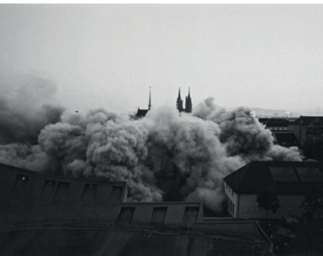
Sprengung des alten Basler Stadttheaters am 6. August 1975
